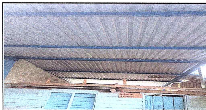
Foto 5: Estructura y techo instalado.
