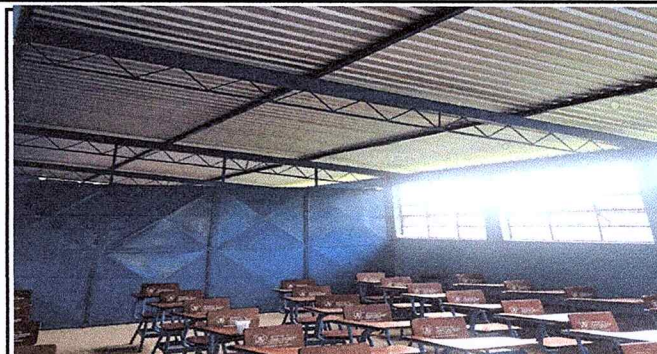
Foto 2: Estructura de techo y lamina instalada.
