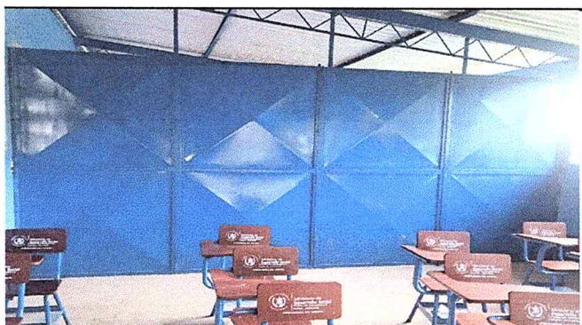
Foto 3: Colocacion de división metálica.
