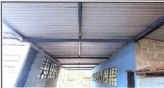
Foto1: Techo instalado en corredor.
