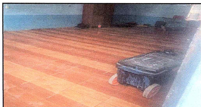
Foto 6: Piso cerámico instalado en direccion.
